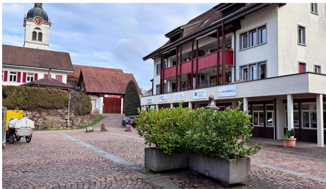
Der Dorfplatz in Oberlunkhofen wird saniert. Bald könnte es hier schon ganz anders aussehen.
